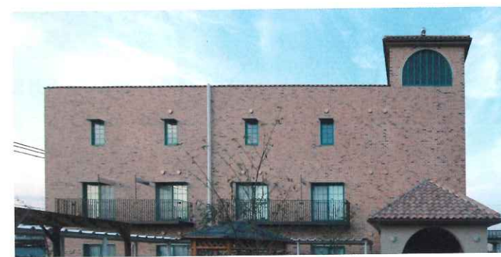
写真7 乾式煉瓦工法の事例。明石に立地するグループホーム「ブーフー」(筆者の設計)
