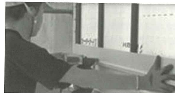
写真8 金物取り付け工事
